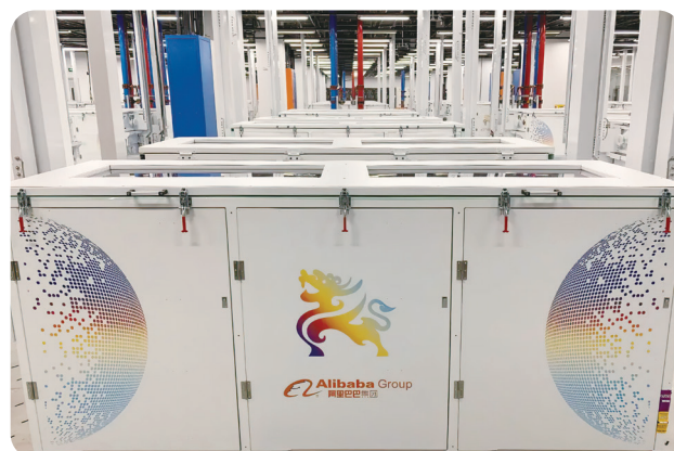
▲ 「浸沒液冷系統服務器」是由阿里雲研發的開創性冷卻技術，可以較傳統機械冷卻更為節能。
